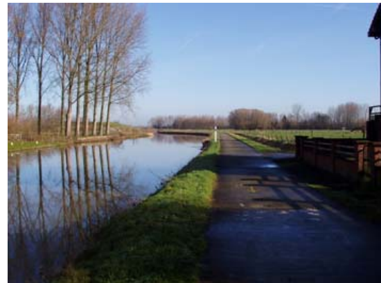
Figure 14 : Rive droite en aval du pont-levis
