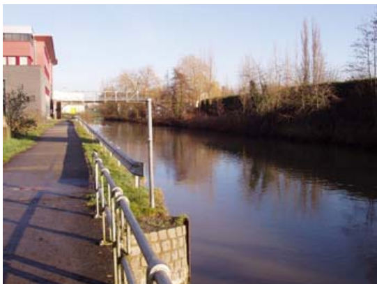
Figure 3 : Amont de la passerelle du Pont Rouge
