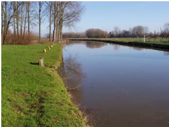
Figure 13 : Rive gauche en aval du pont-levis
