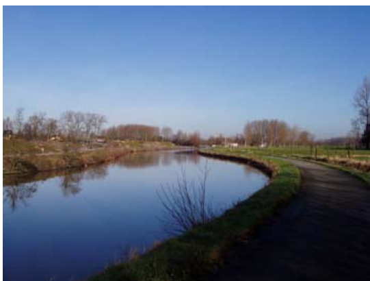
Figure 15 : Amont de l'écluse de Rebaix
