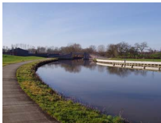
Figure 6 : Amont de l'écluse de Bihée
