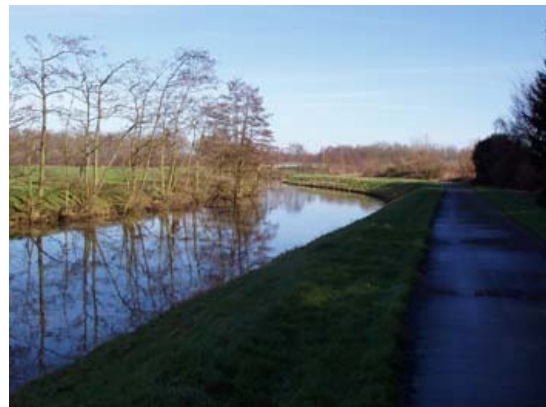
Figure 24 : Aval de l'écluse de Papignies
