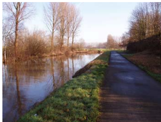
Figure 8 : Aval de l'écluse
