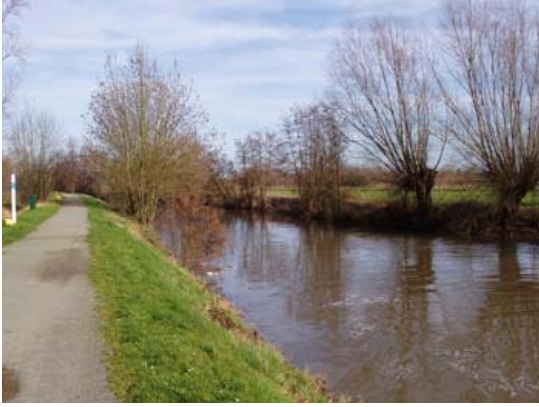
Figure 37 : Surplomb en aval de l'écluse
