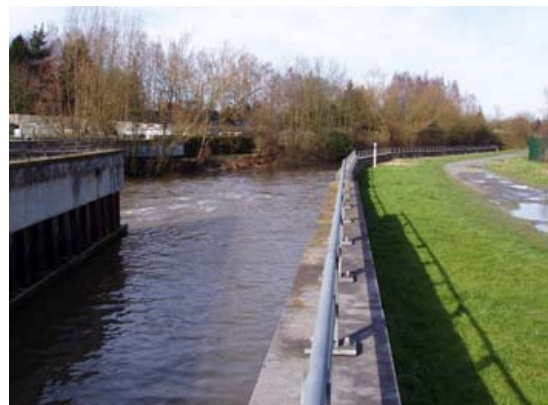
Figure 32 : Aval de l'écluse de Lessines
