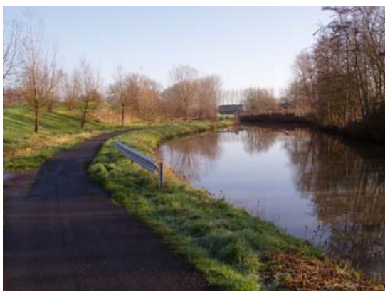
Figure 5 : Aval du pont n° 2 du contournement
