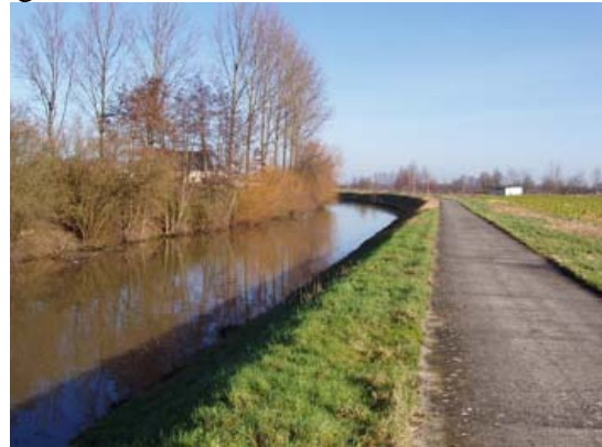
Figure 18 : Aval de l'écluse de Rebaix
