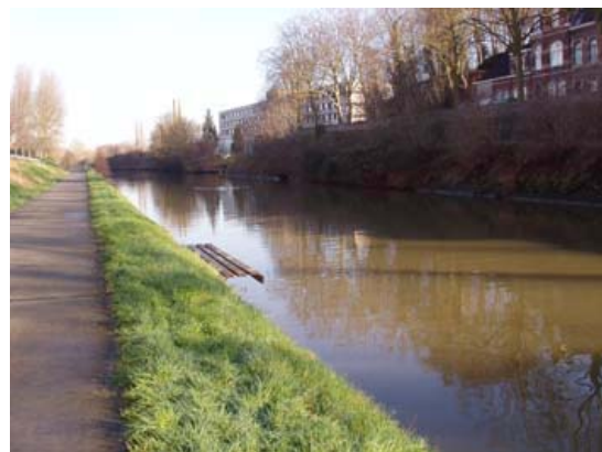
Figure 2 : Aval du pont
