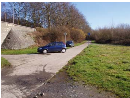
Figure 25 : Pont « Boulevard Branquart »
