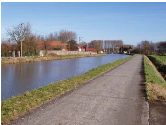
Figure 23 : Amont de l'écluse de Papignies
