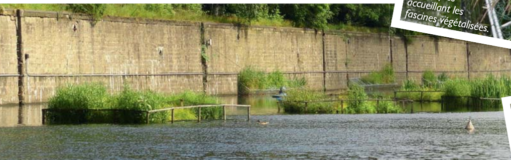
Vue partielle des aménagements de restauration effectués à la darse de Cheratte.
