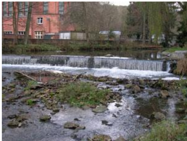
Photo 18. Obstacle « important » (n° 1455 62 ) dans le segment 7B (25/11/2005).
