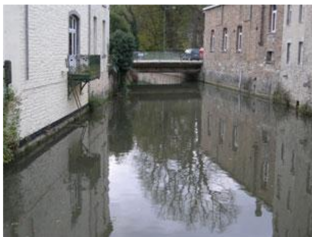
Photo 19. Le Bocq dans le centre d'Yvoir, segment 7E (25/11/2005).
