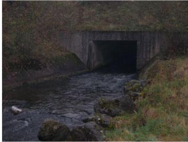
Photo 13. Photo prise en aval du pertuis (21/11/2005).
