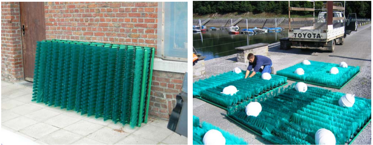
Figure 6.4. Montage des frayères artificielles flottantes composées de fibres de polypropylène (type SOVB).
